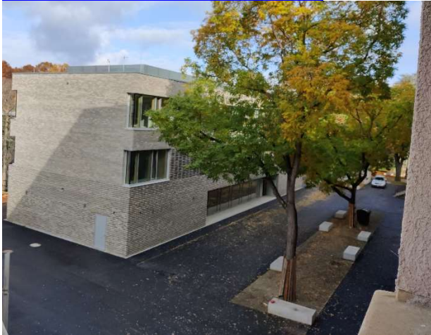
Blick aus dem Hauptgebäude auf den Neubau
